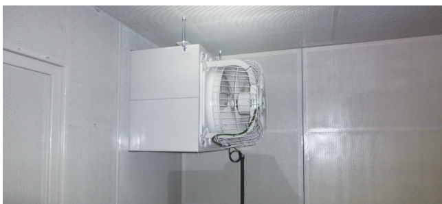
防音ボックス内 換気扇にサイレンサーの設置
