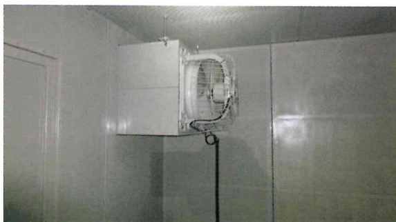
防音ボックス内 換気扇にサイレンサーの設置
