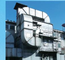
触媒式脱皂装置
